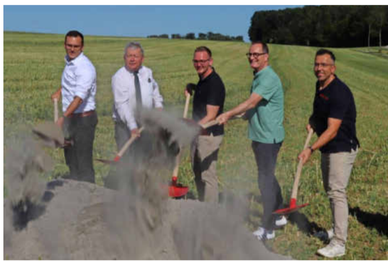
Kevin Möhler (Mitte) eröffnet gemeinsam mit Politikern und Marco Göbel vom Öhringer Montageunternehmen symbolisch die Baustelle.
